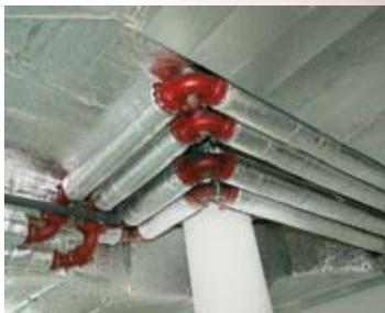
Гибкие муфты Grinnell также справятся с несовпадением трубопроводов. Компенсируется такое несовпадение определенным запасом углового отклонения. *Тепловое расширение?* При использовании гибких муфт допускается смещение на несколько миллиметров на одну муфту. При правильном конструктивном решении можно сэкономить на использовании трубных компенсаторов. Муфты Grinnell позволяют снизить уровень шума и вибрацию от насосов и охлаждающих аппаратов.
