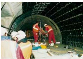
В туннелях или на мостах изделия со шлицами Grinnell используются для слива жидкости, подачи питьевой воды, сжатого воздуха и противопожарной защиты. В данном случае гибкие муфты используются для того, чтобы трубы могли прокладываться с учетом изменения направления и общей линии следования туннеля или моста.
